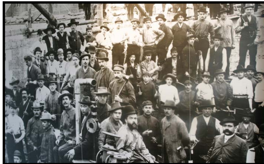
Werklieden bouw sluis
