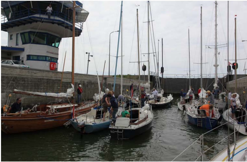
001 Sluis Den Oever
